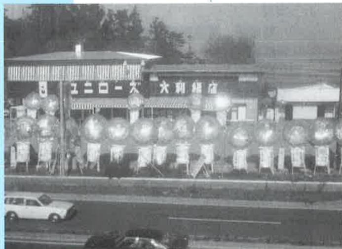
最初の大型店として開店した大利根店の外観
